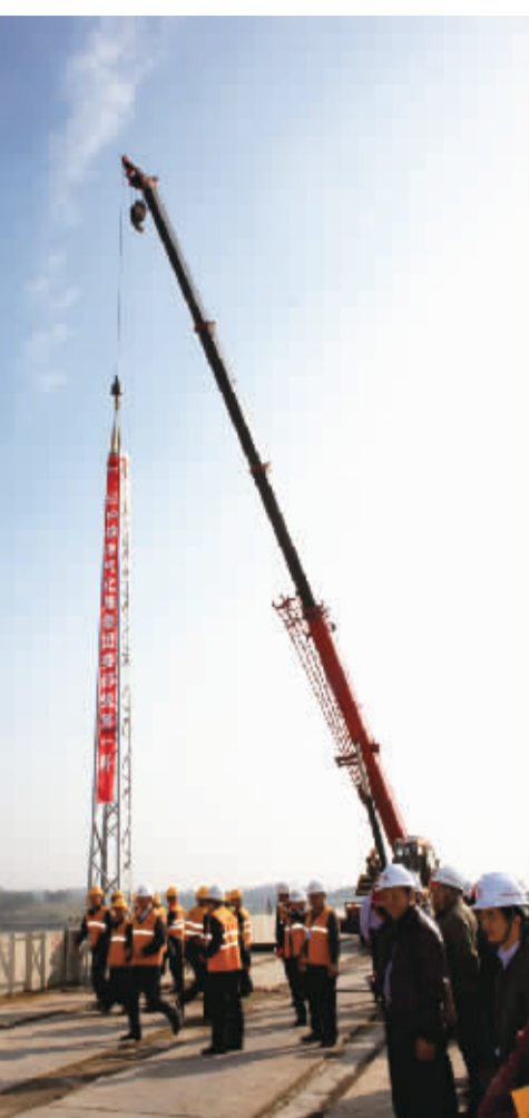
● 娄邵电气化铁路改造第一杆
