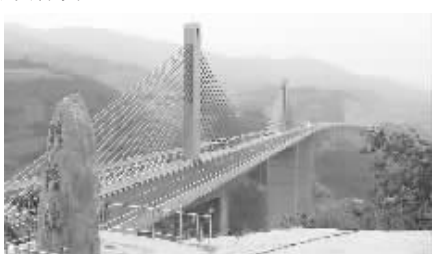
●南盘江特大桥
