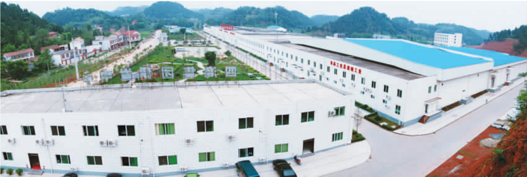
● 四海集团生猪屠宰厂区一角
