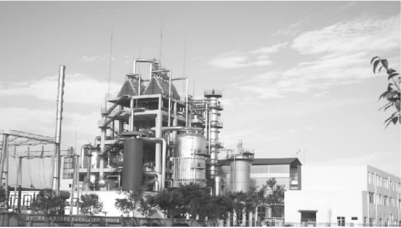
●成都玉龙化工有限公司具有国际领先技术的三胺装置
