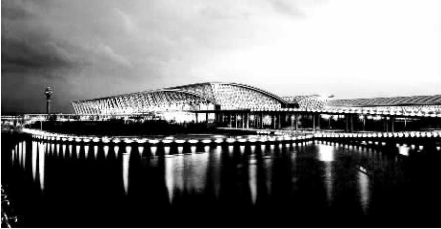
●由中国五冶集团承建的上海浦东国际机场工程获得 1999 年度上海市优质工程“金刚奖”。
