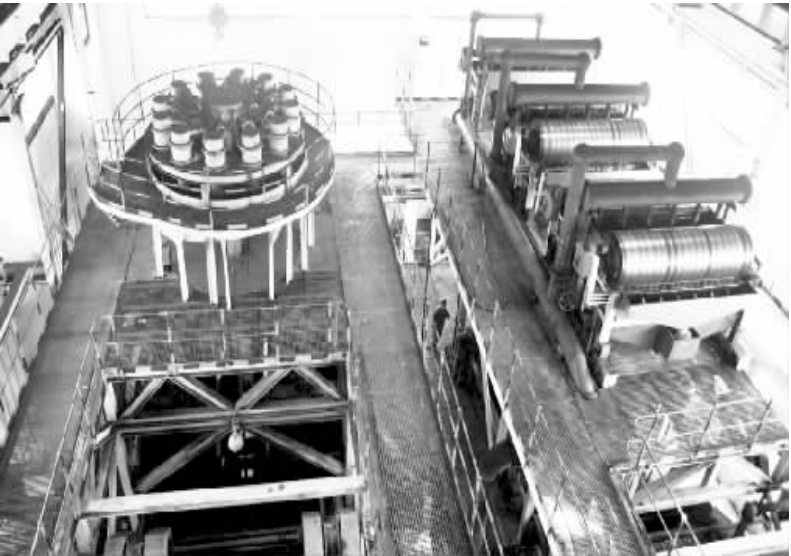
●现代化的重介洗煤厂
