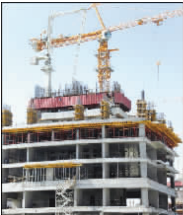
●巴林的Marina-West-楼盘,11栋高40层的公寓楼,4家混凝土公司都采用三一设备施工。
