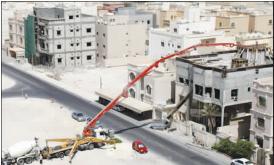
●三一泵车参与了诸多巴林重大工程建设施工。
