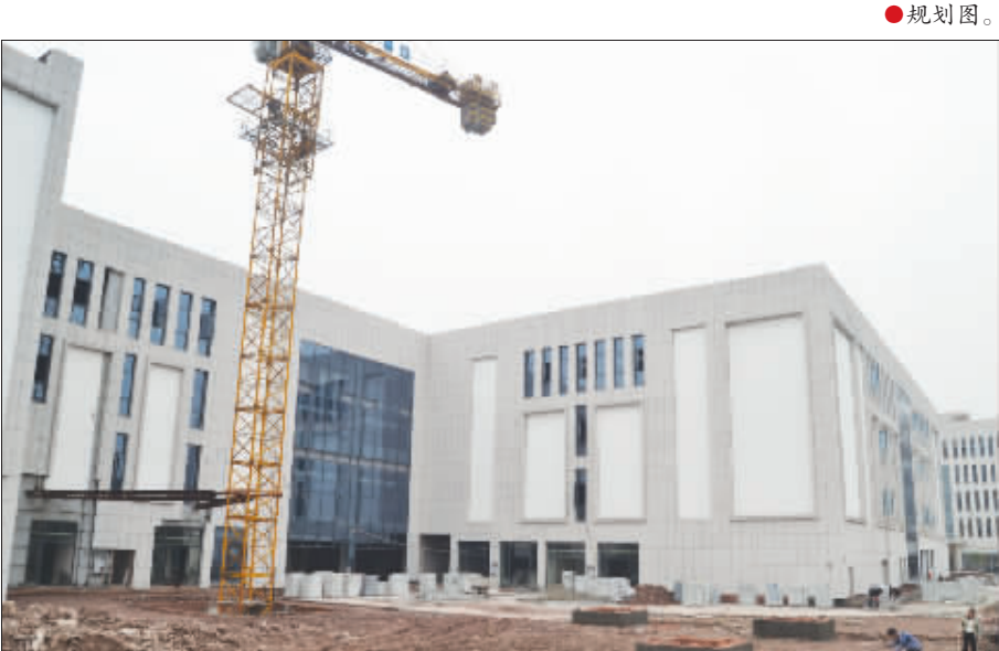
● 万商国际五金机电城目前一期工程已竣工，正处于内部装修和外部环境(广场)打造阶段，预计 12 月底通过综合验收。
