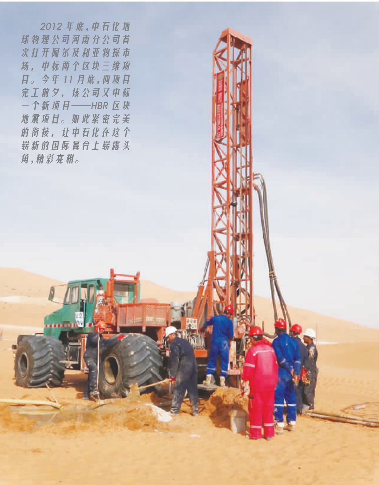
● 沙漠钻机正在打井施工
