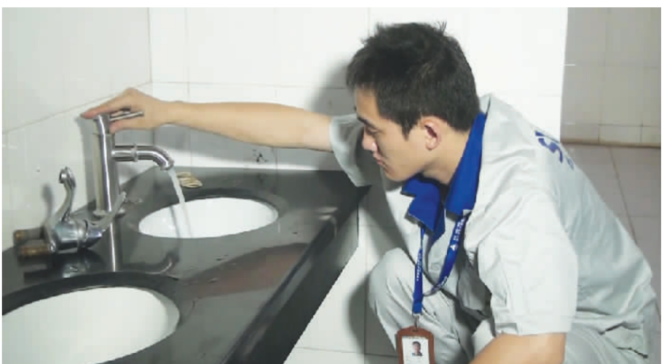
●某品牌产品的工作人员免费为幼儿园更换无铅龙头。
