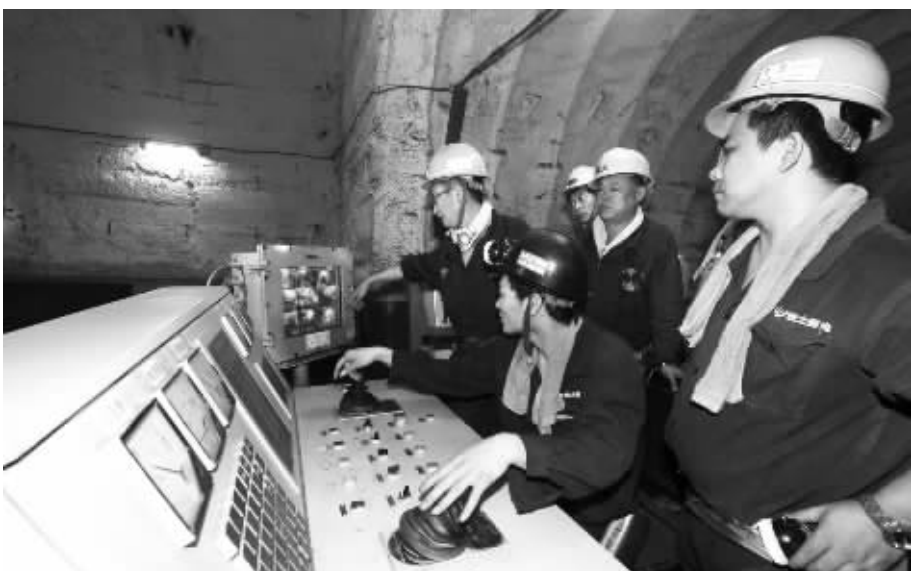
●图为运输区负责人介绍轨道绞车安全监控系统。
