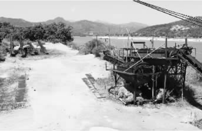
◎有17年历史的闽诚砂石有限公司已倒闭，设备已生锈
