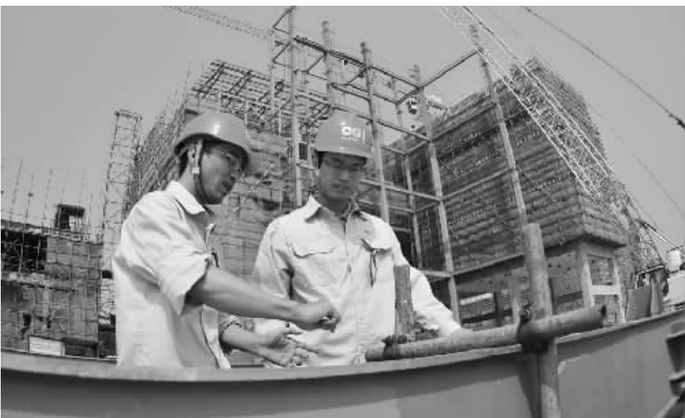
▲2012 年,中电投钦州热电项目进入大规模实质性施工建设阶段。图为建设者正在紧张施工中
