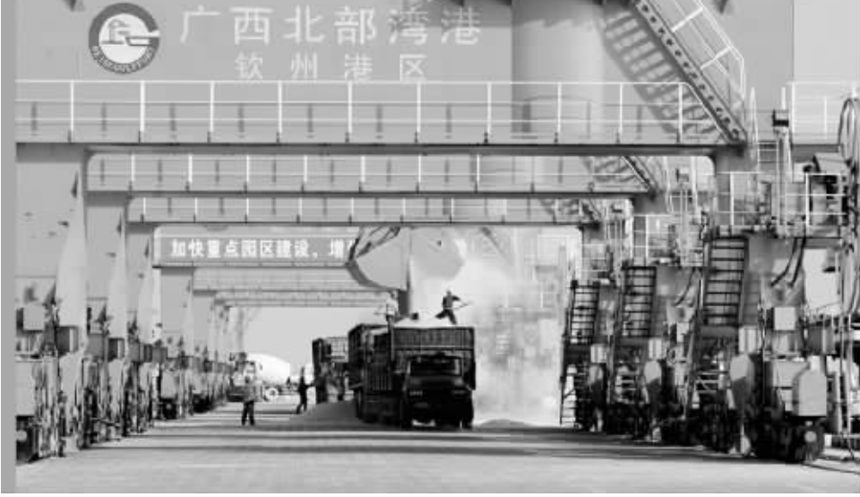
▲2012 年,随着钦州港 30 万吨级主航道竣工,30 万吨级油码头水工部分建成,钦州港港口吞吐能力已达 1 亿吨。图为钦州港大概坪 10 万吨级码头雄姿
