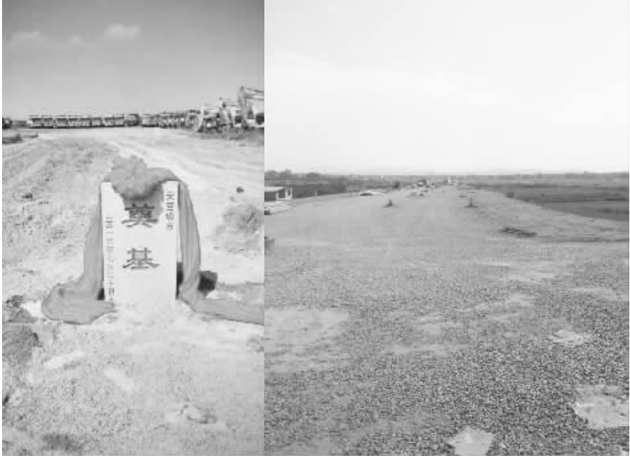
●天空城市建设现场
