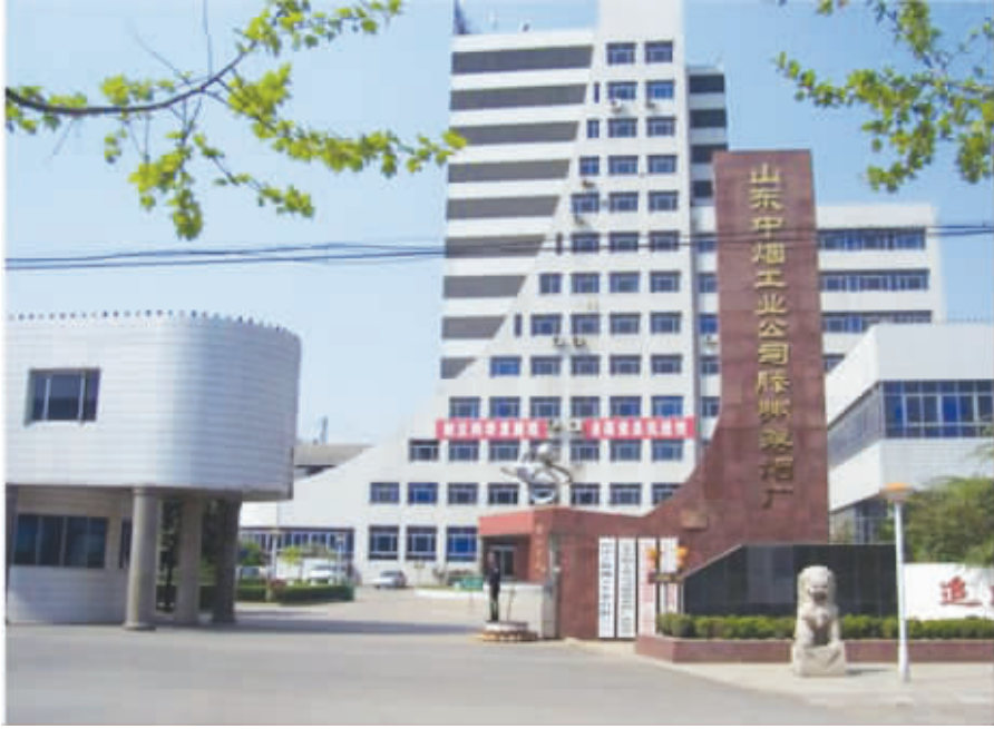
●冠华机电工程项目实拍图。
