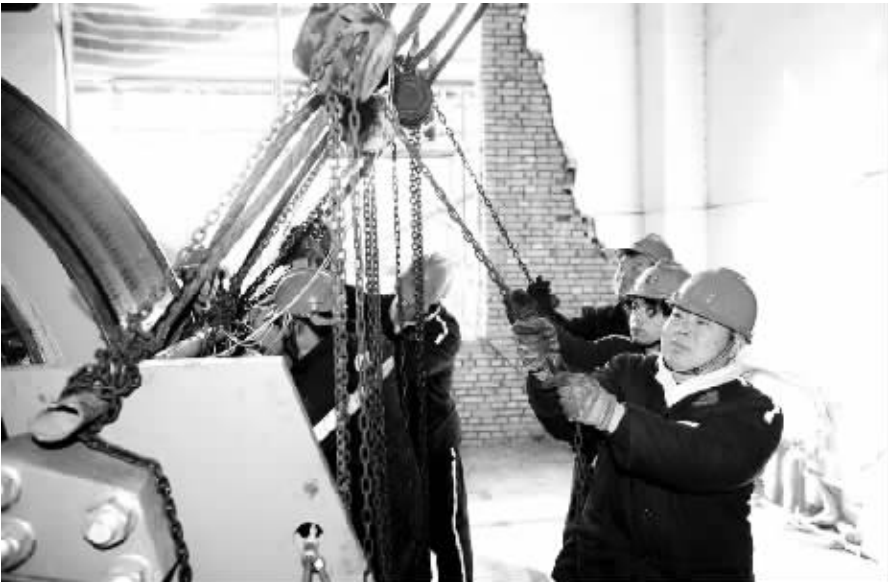
图为12月18日,几名突击队员正在紧固绞车钢丝绳的情景。
