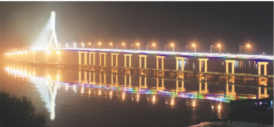
◎ 赤道几内亚 Mbini 大桥项目
