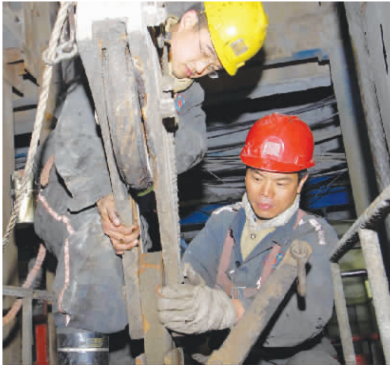
图为王钢经(右)和班组职工在检修副井罐笼。
