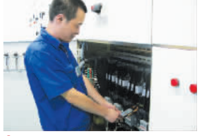
②图为维修工对主要用电负荷线路的负荷值进行测量。
