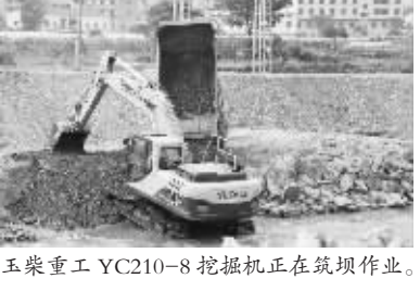
玉柴重工YC210-8挖机正在筑坝作业。
