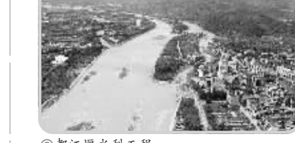
©都江堰水利工程。
