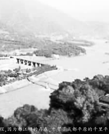
©一项伟大的古代水利工程,因为都江堰的存在,才有了成都平原的千里平川和“天府之国”的产生。被称为古代水利的灿烂明珠。
