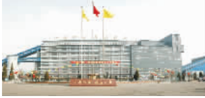
◎太西洗煤厂外景。
