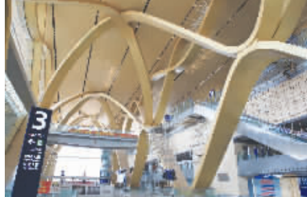
昆明长水国际机场航站楼内象征着七彩云南的金色彩带代替柱子支撑着整个航站楼。
