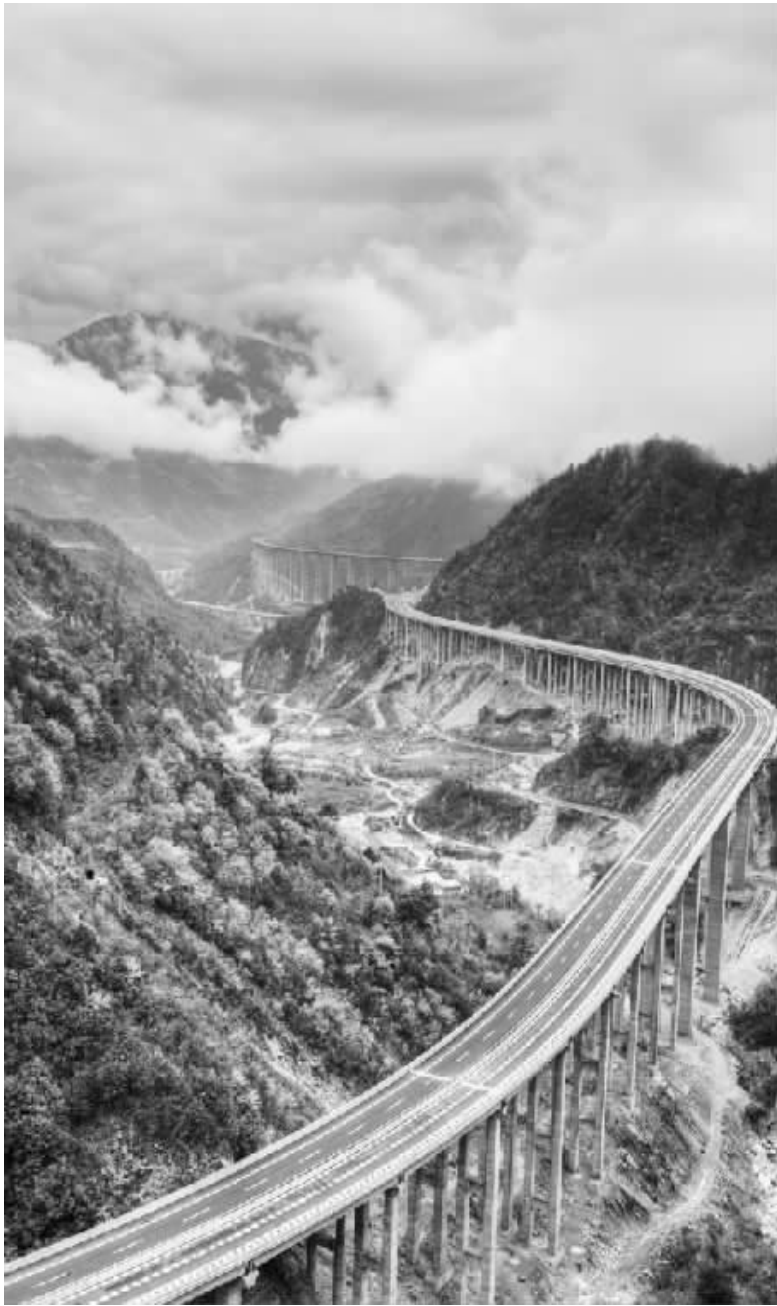
©已建成通车的雅安至西昌高速公路(远眺干海子特大桥)李明春 摄
