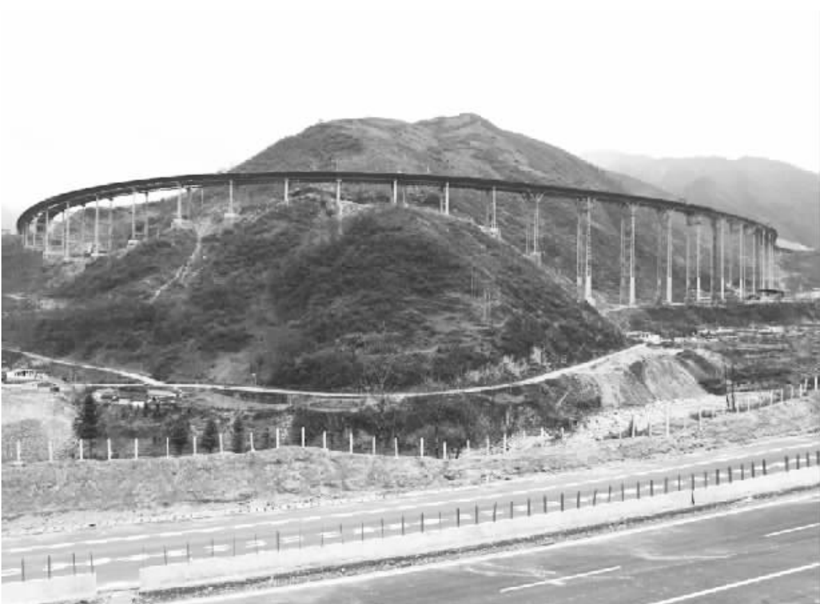
图为正在建设中的干海子特大桥（李明春摄）
