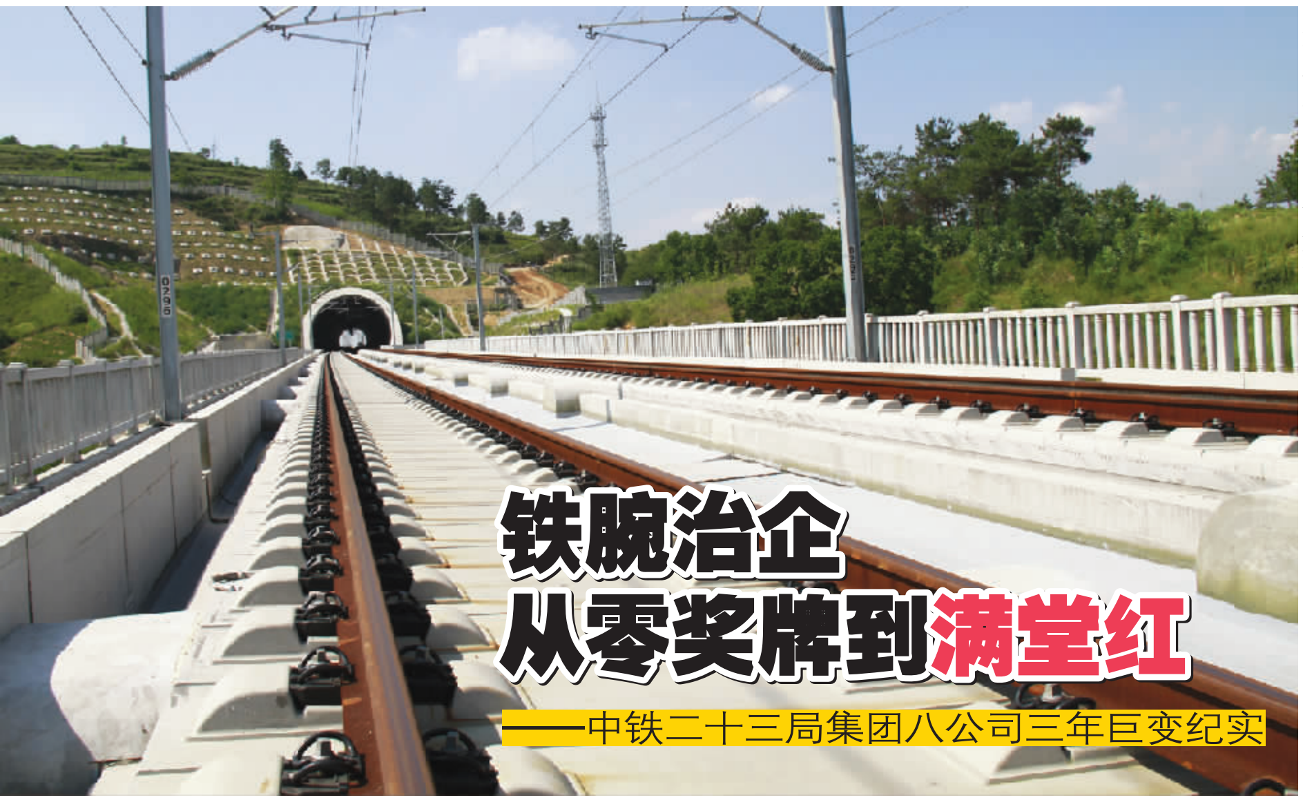
⑧八公司担负施工的红塘冲大桥无砟轨道
