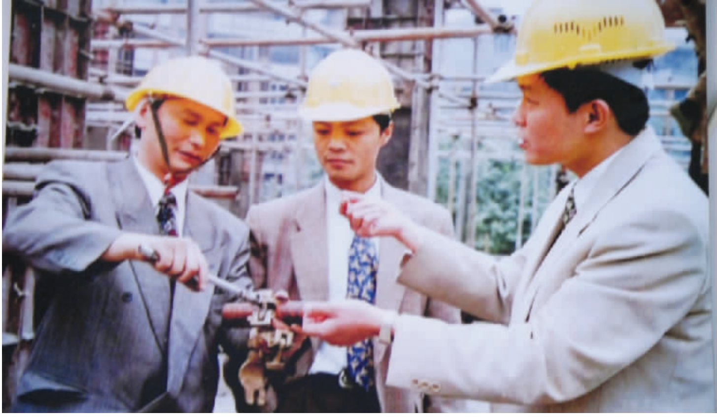
陈远宪（左一）亲临施工现场与建筑客商在一起。
