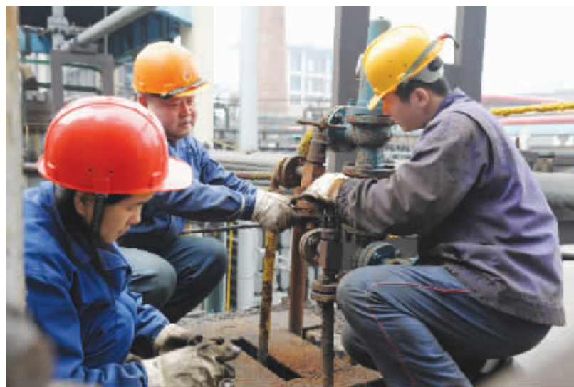
合成氨厂钳工更换仪表
