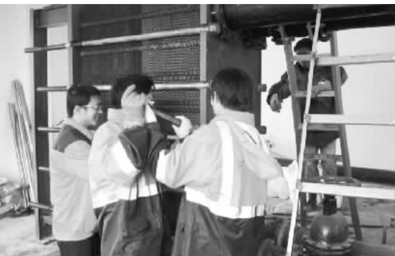
为改善填埋场渗滤液处理站污泥冷却系统热交换效果,江苏苏州七子山垃圾填埋场渗滤液处理站机修员在江苏维尔利环保有限公司技术人员指导下对生化冷却板式换热器进行拆装清洗。
