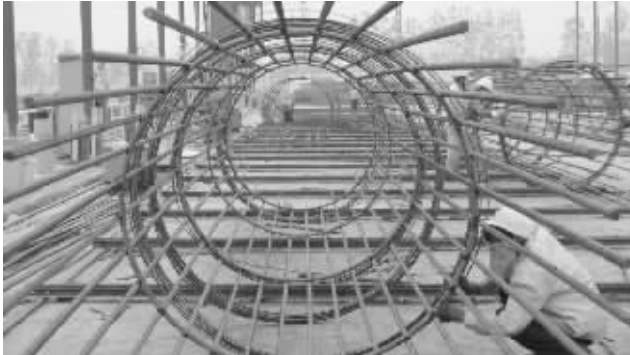
图为江南项目部二分部员工正在加班加点制作桥桩钢筋笼。周安才 摄影报道
