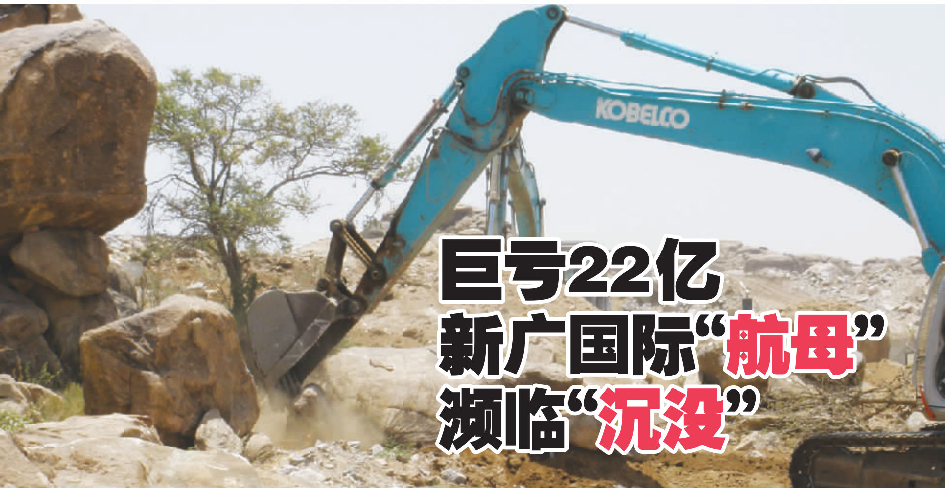
©2009年5月新广国际沙特哈立德大学项目动工开挖
