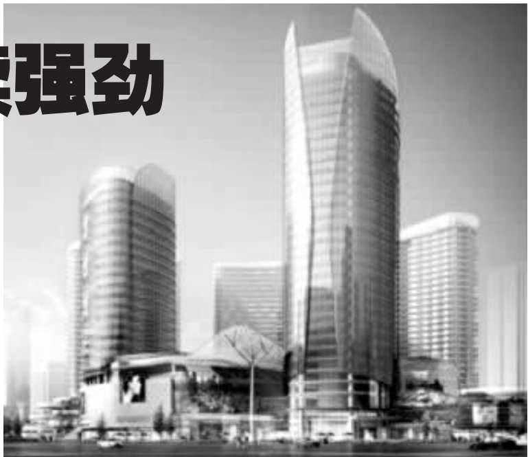
成都城南正在修建的甲级写字楼
