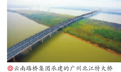
◎云南路桥集团承建的广州北江特大桥
