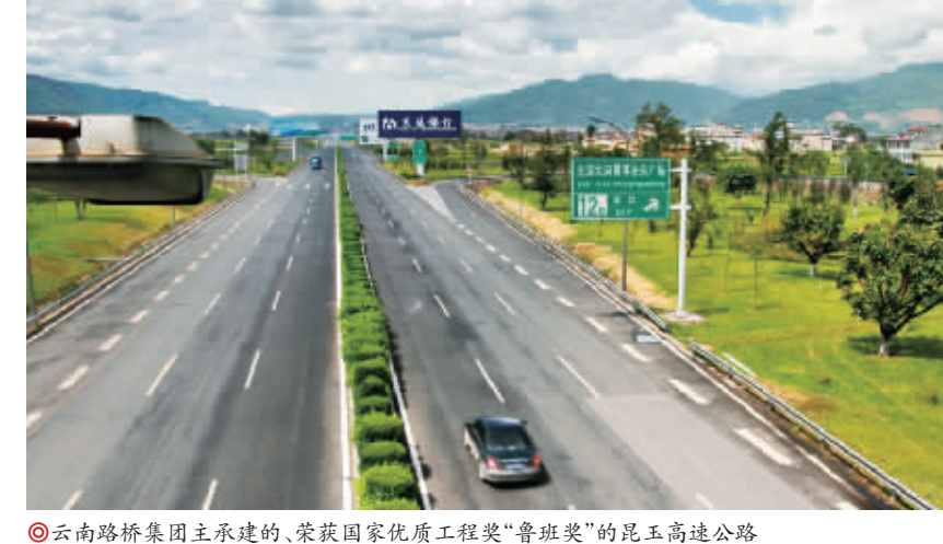
◎云南路桥集团主承建的、荣获国家优质工程奖“鲁班奖”的昆玉高速公路
