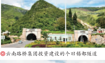
◎云南路桥集团投资建设的个旧锡都隧道
