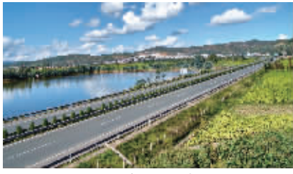
◎云南路桥集团承建的楚大高速公路
