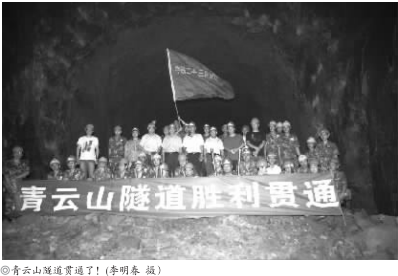
青山隧道贯通了! (李明春 摄)
