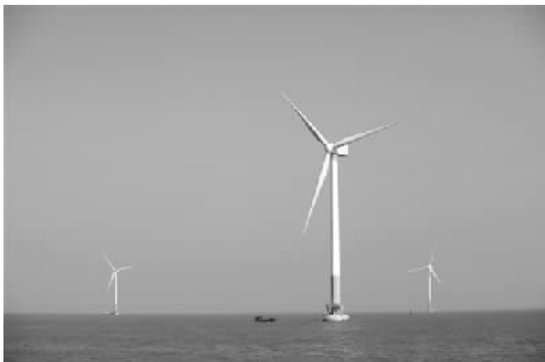
华锐风电 3MW 海上风电项目。
