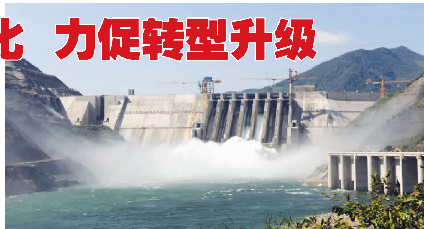
中国水电七局承建的世界最高碾压混凝土大坝——龙滩水电工程大坝
