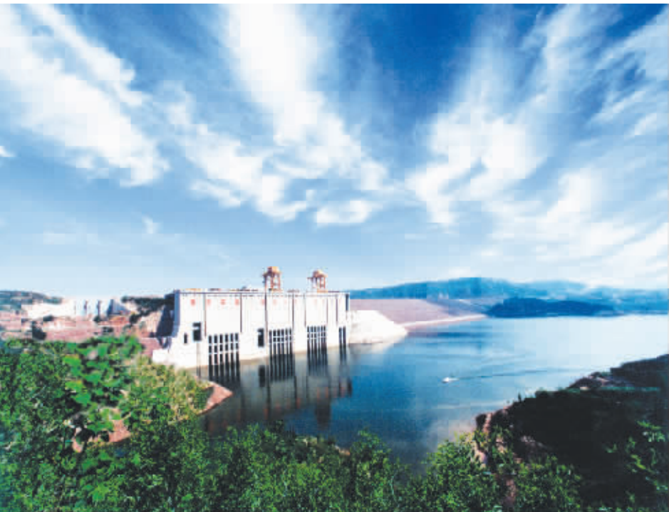
中国水电七局参建的河南小浪底水利枢纽工程荣获鲁班奖
