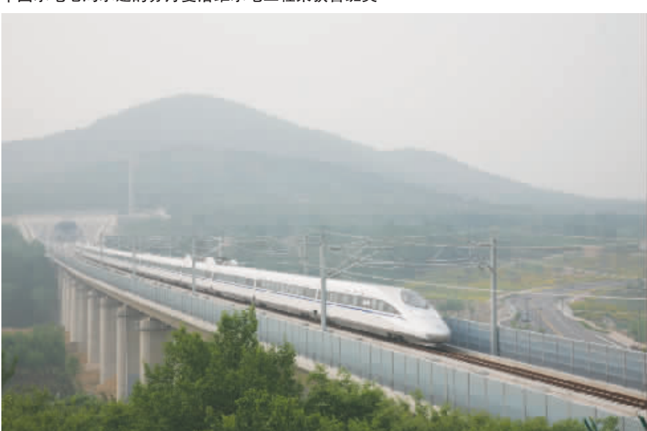
中国水电七局承建的京沪高铁凤凰台隧道和陡山沱特大桥顺利建成通车
