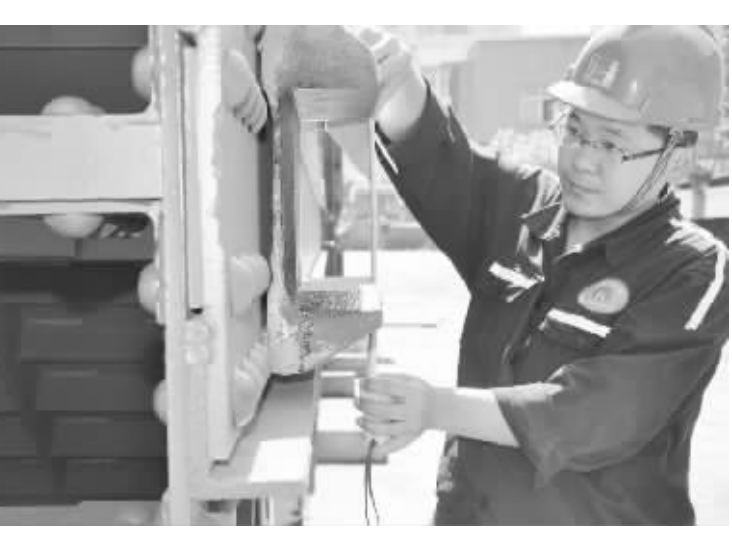
图为 5 月 13 日刘文杰正在许疃煤矿主井系统改扩建工程工地查验待安装设备。
