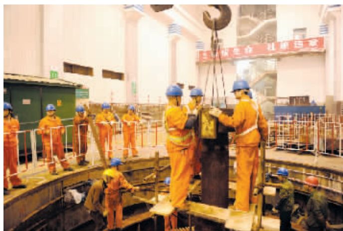
“5·12”地震中，严重受损的映秀鱼子溪电站，去年“8·13”洪水再次严重损毁。图为工人正在修复受损的机组。
