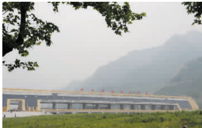
江苏省援建的绵竹市宋坝堰取水枢纽恢复重建工程
