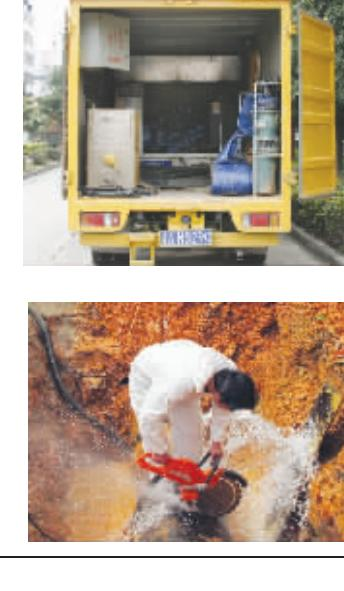
在进行切管作业时经常使用到的“手术刀”。在进行大管径的水管切割作业时，抢修人员为了减少停水时间，就利用爬管刀对水管进行预切割，然后再用大型割管刀来对管道进行快速切割，大大提高了抢修工作的效率和企业的效益。
