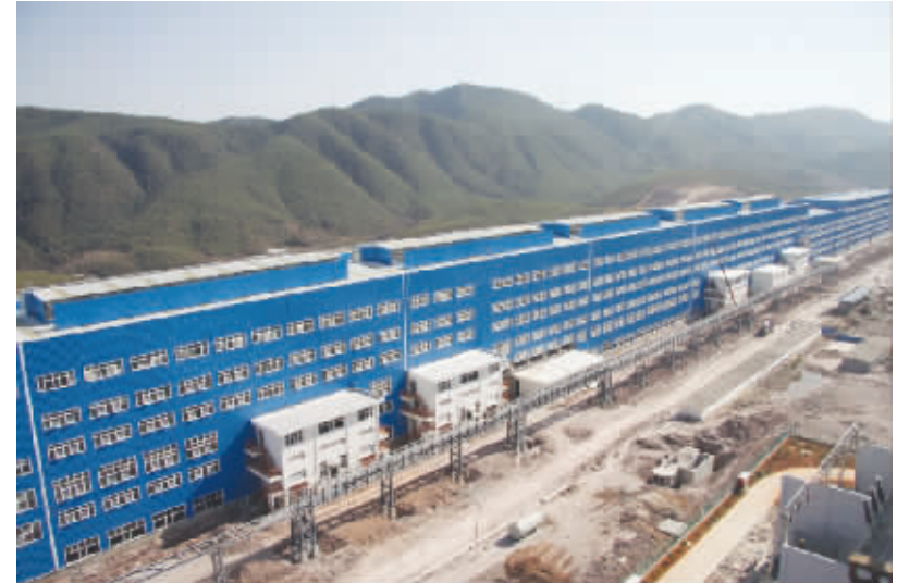
云南冶金集团新立公司在建海绵钛生产区
