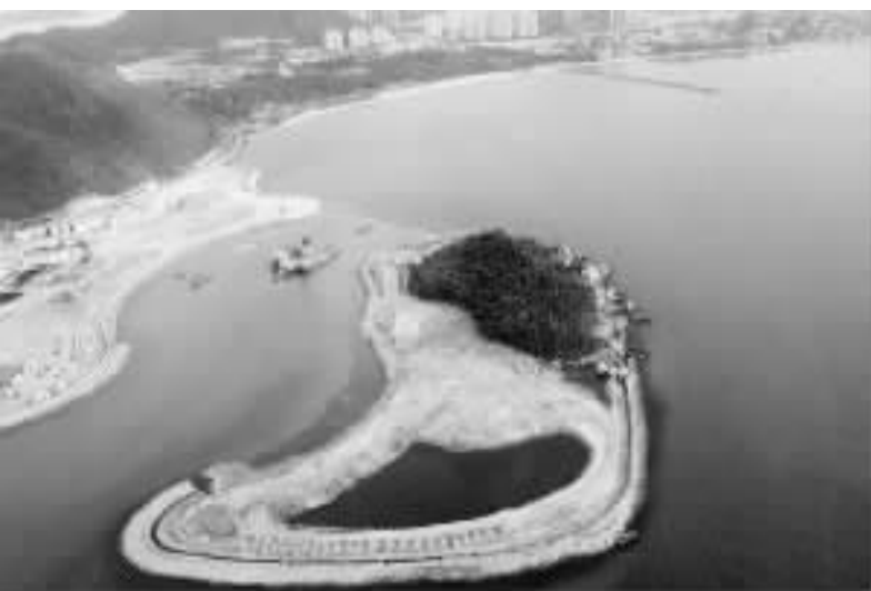
3月9日,三亚鹿回头半岛洲际酒店抓紧建游艇码头。到今年年底,三亚市预计建有泊位将超过1000个。
