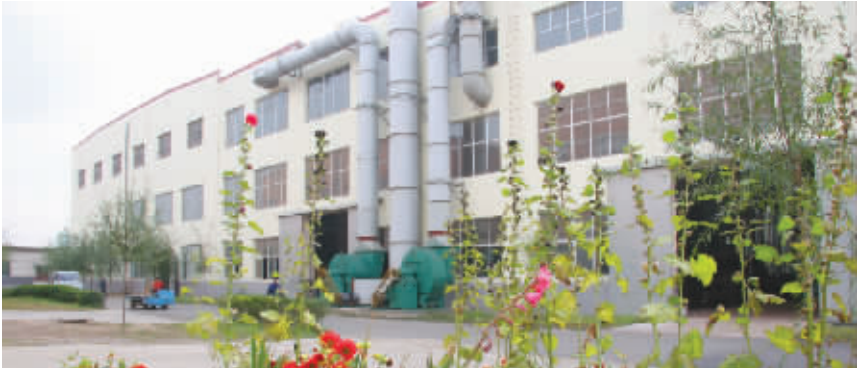
四平鼓风机股份有限公司厂内车间
