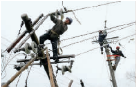
1月2日,贵州省丹寨县供电局工作人员在修复因冰凝灾害损坏的供电线路。 黄晓海 摄影
