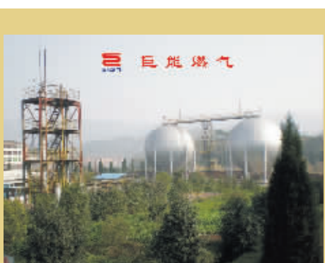
◎巨能公司储气罐
