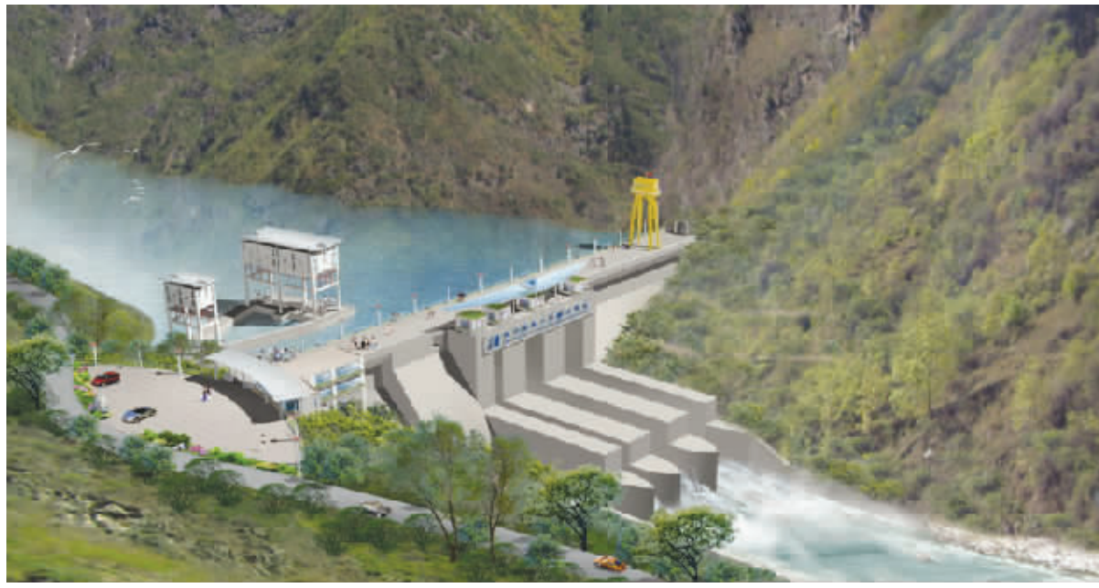
瓦斯河二期水电开发工程。
