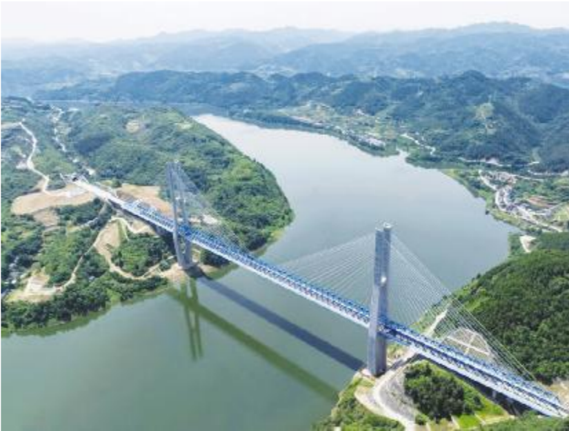
●西十高铁汉江特大桥(6月28日摄,无人机照片)。新华社记者 伍志尊 摄
