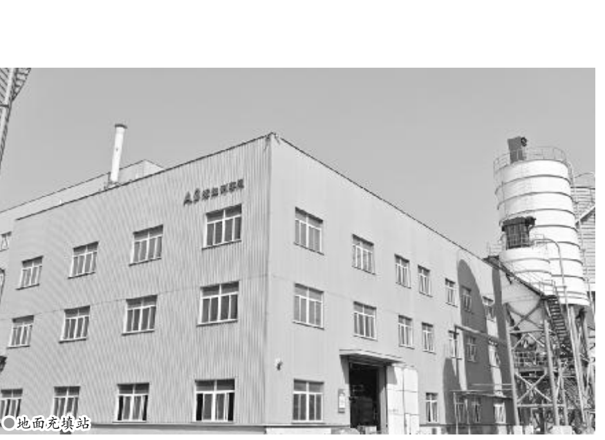
南屯煤矿充填站
