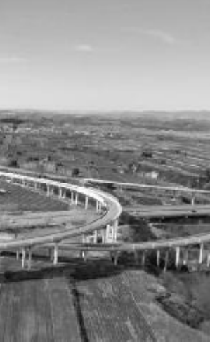
● 这是西北最大路分布式光伏枢纽示范项目——大庄枢纽电站。
