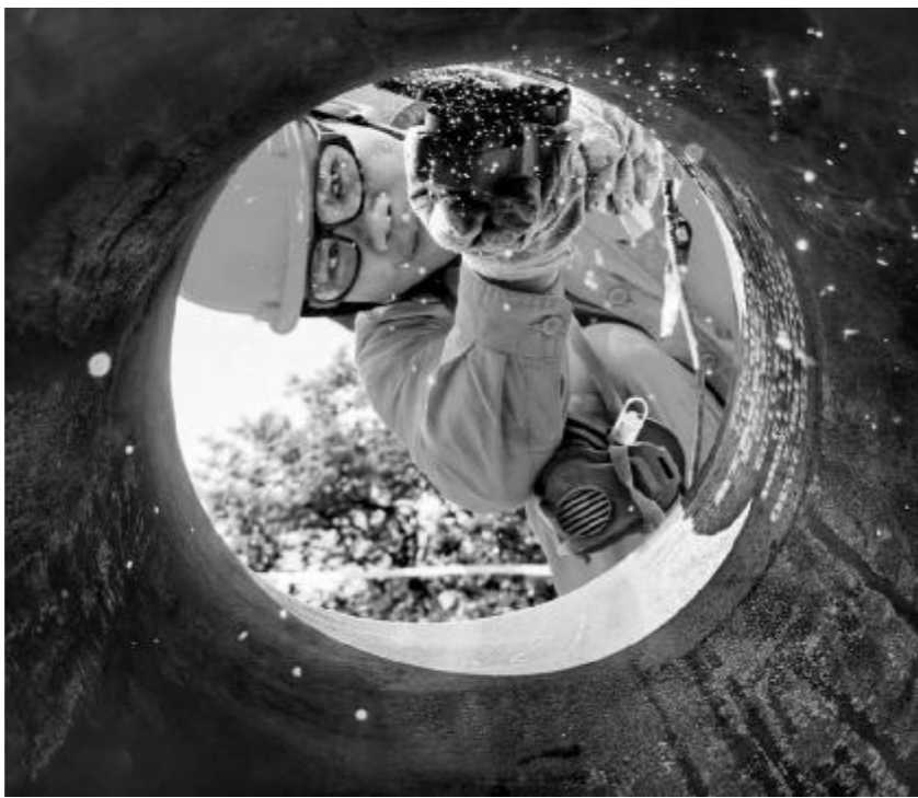
● 施工人员进行打磨管道。
