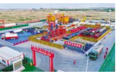
● 丰页 12 号台电驱压裂施工现场
